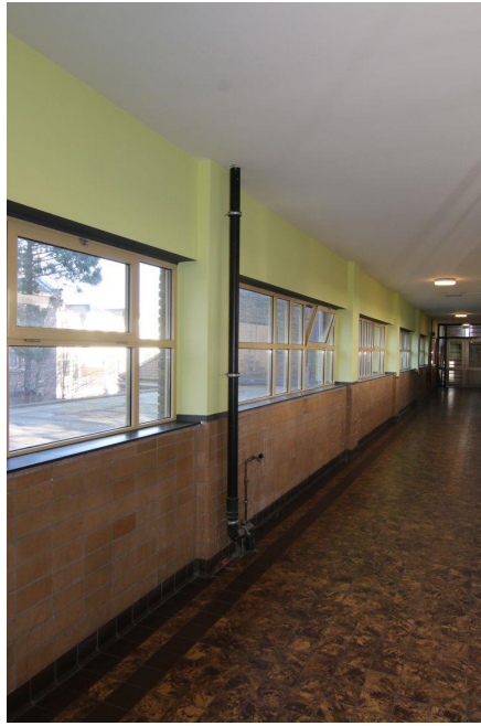
Afb. 53 Overzicht vernieuwde gangramen in buitengevel 1 ste verdieping
