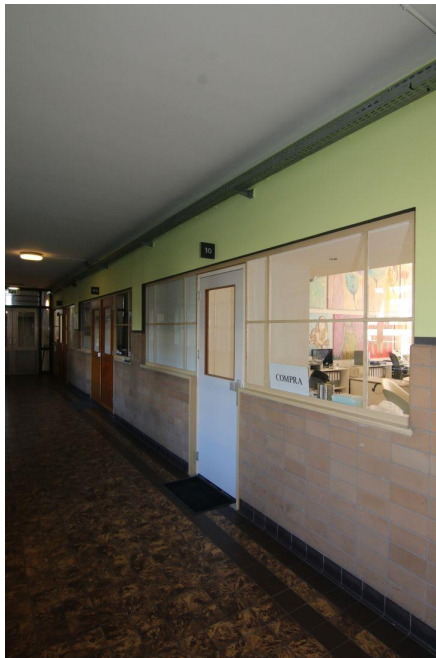
Afb. 56 Enkele deur in bestaand stalen gangraam
