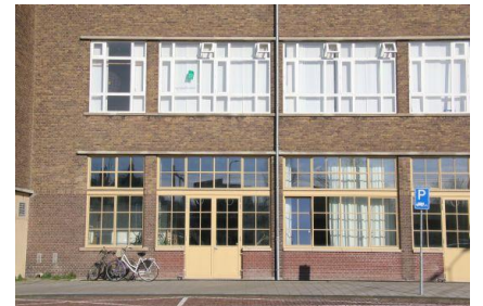
Afb. 39 Detail voorgevel met verplaatste dubbele deuren
