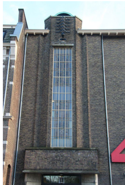
Afb. 32 Overzicht buitenkant trappenhuis
