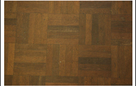
Afb. 60 Detail parketvloer vm. houtbewerkingslokaal
