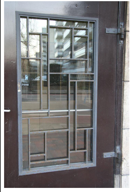
Afb. 30 Siersmeedwerk in voordeur
