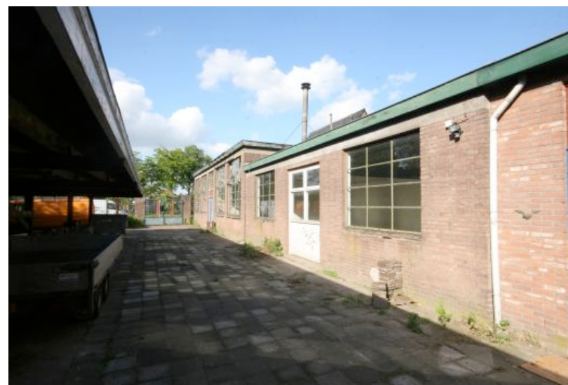
Afbeelding 64: Metselwerkplaats met oudste uitbreiding
