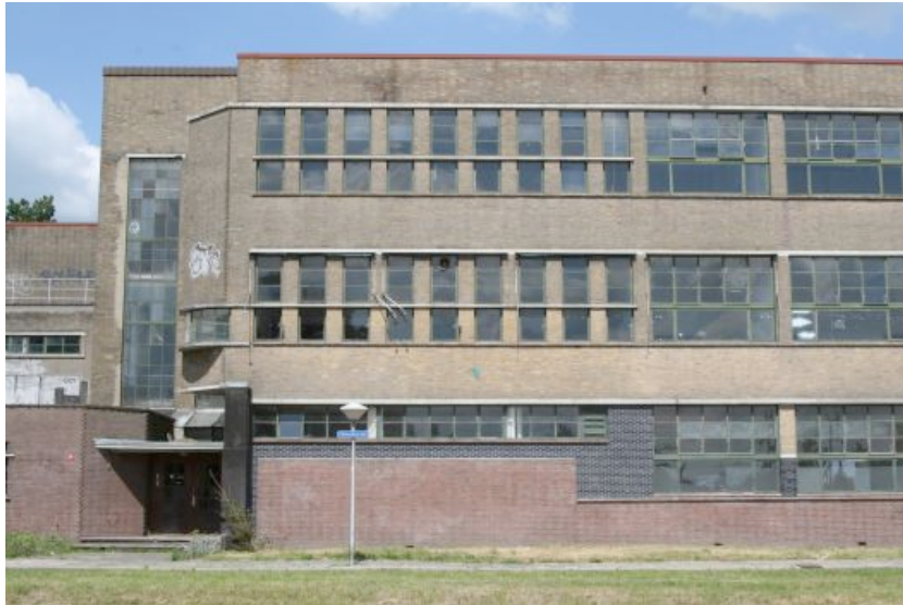
Afbeelding 47: Gevarieerd gevelbeeld Mimosavleugel
