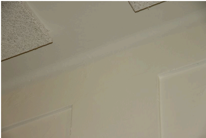
Afbeelding 69: constructie eerste verdieping Mimosavleugel
