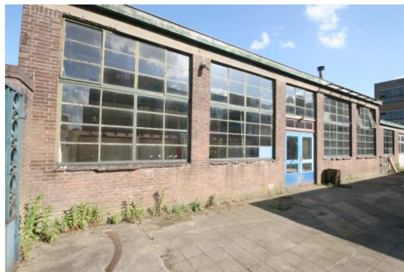
Afbeelding 66: metselwerkplaats gezien vanaf het hek
