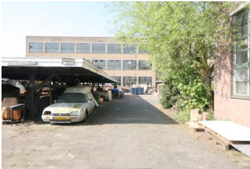
Afbeelding 57: Mimosavleugel gezien vanaf plein
