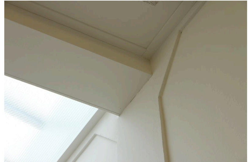
Afbeelding 72: constructie tweede verdieping Hortensivleugel bij daklicht
