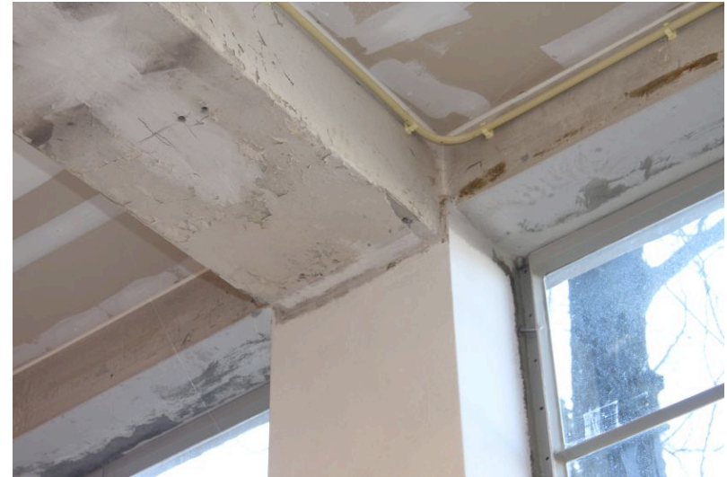
Afbeelding 68: balk lokaal begane grond
