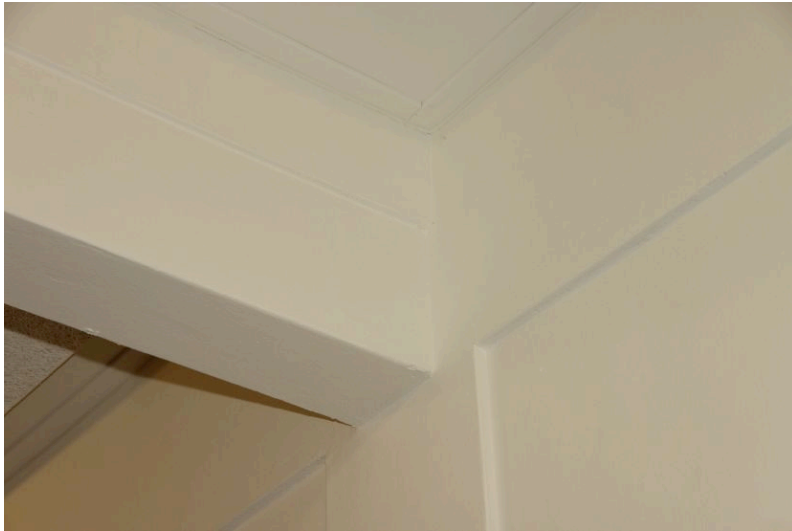
Afbeelding 71: constructie tweede verdieping Mimosavleugel
